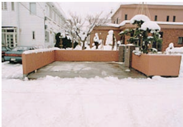
路面融雪 (ロードヒーティング) や 電熱又は温水制御自動化
